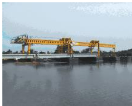
在印度科钦施工架设铁路槽型梁
