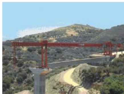
在希腊卡拉马塔施工架梁
