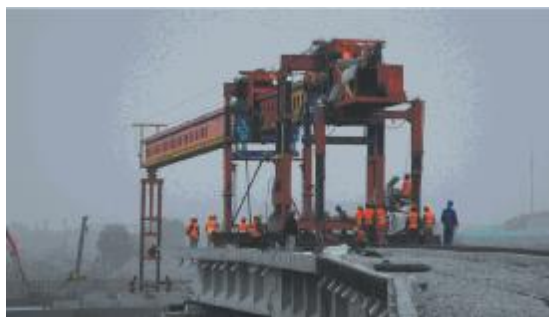
在南京沪宁高铁联络线施工架梁
