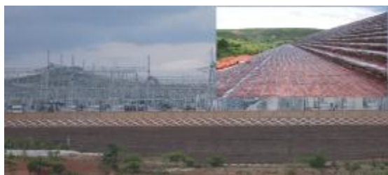
云广特高压工程楚雄换流站土工格栅加筋土高边坡
