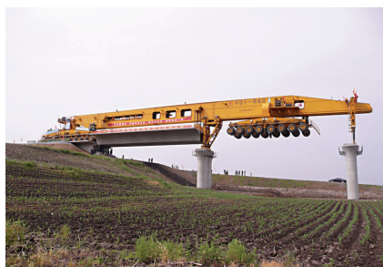
SLJ900-32 流动式架桥机—落梁状态
