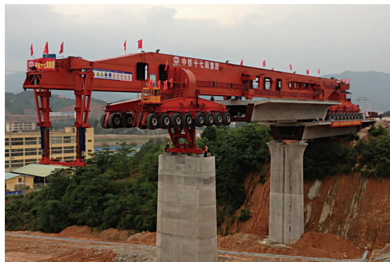
SLJ900-32 流动式架桥机—重载过孔状态
