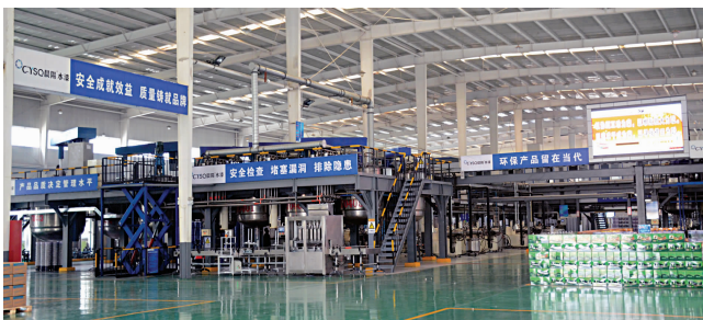
建成的水性漆生产线
