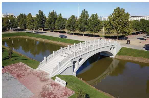
装配式混凝土 3D 打印赵州桥
