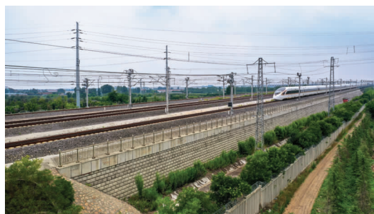
高铁列车在城际铁路加筋土挡墙上驶过
