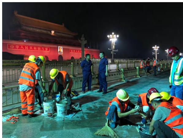
低碳利废水泥在北京长安街天安门段快速修补中的应用
