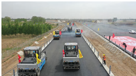
实现沥青路面无人驾驶机群摊铺压实规模化施工
