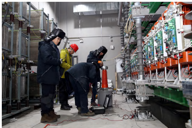
张北柔性变电站工程现场调试
