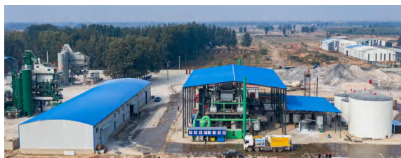
连续式超高掺量胶粉改性沥青智能生产线
