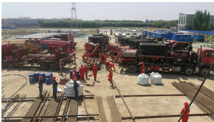
雄安新区深部热储压裂增产试验
