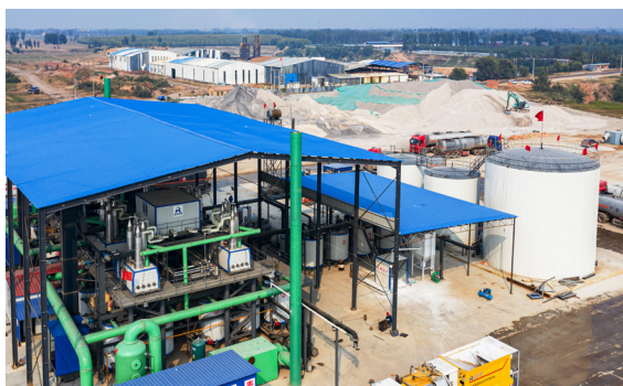
一体化橡胶改性沥青智能生产装备
