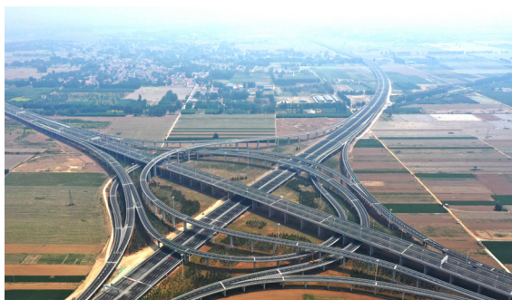
雄安新区荣乌高速新线长寿命路面
